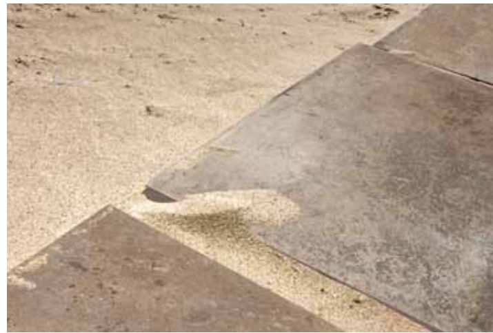
Posa su ghiaia o sabbia
